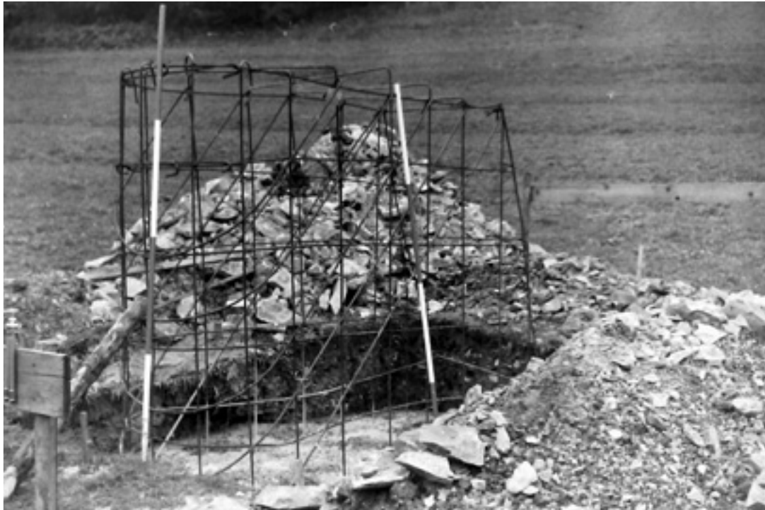
Drahtkorb für das Fundament der Antriebsstation
