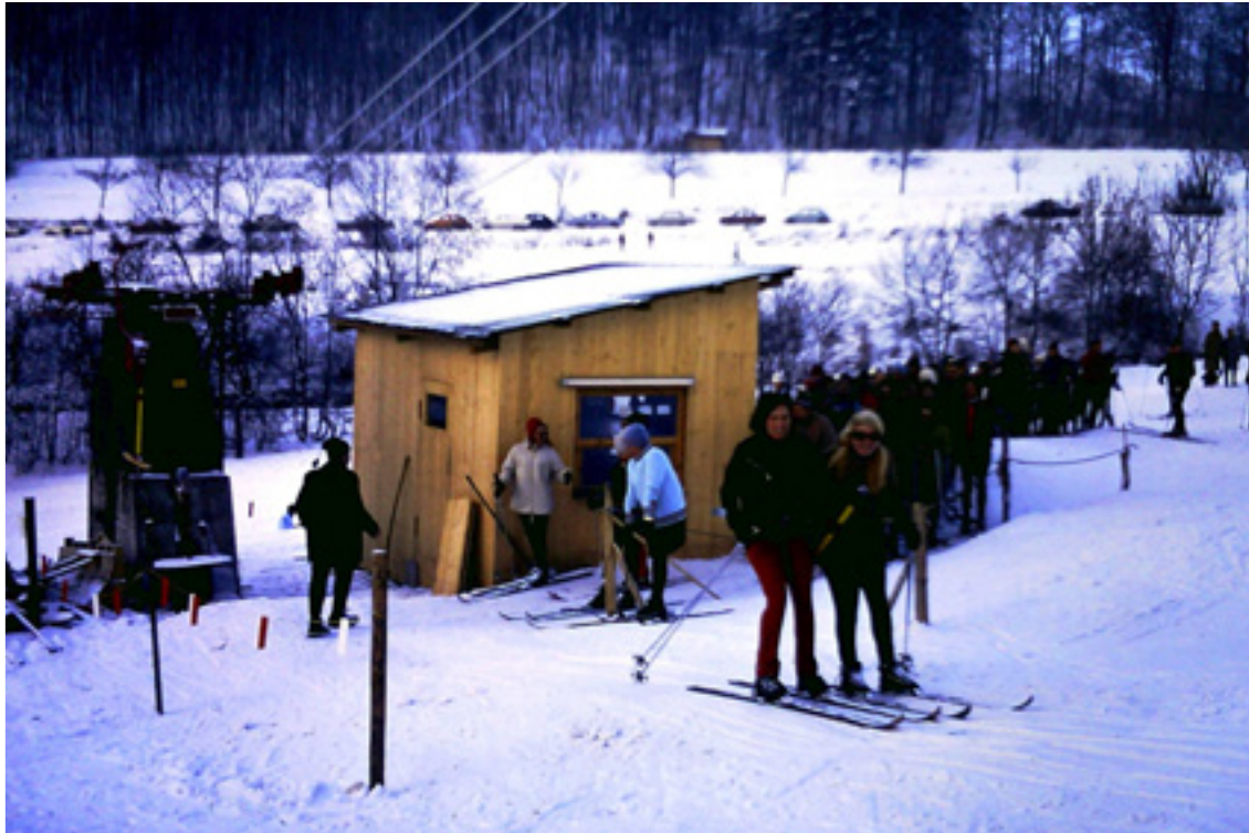
Talstation mit Kassenhaus
